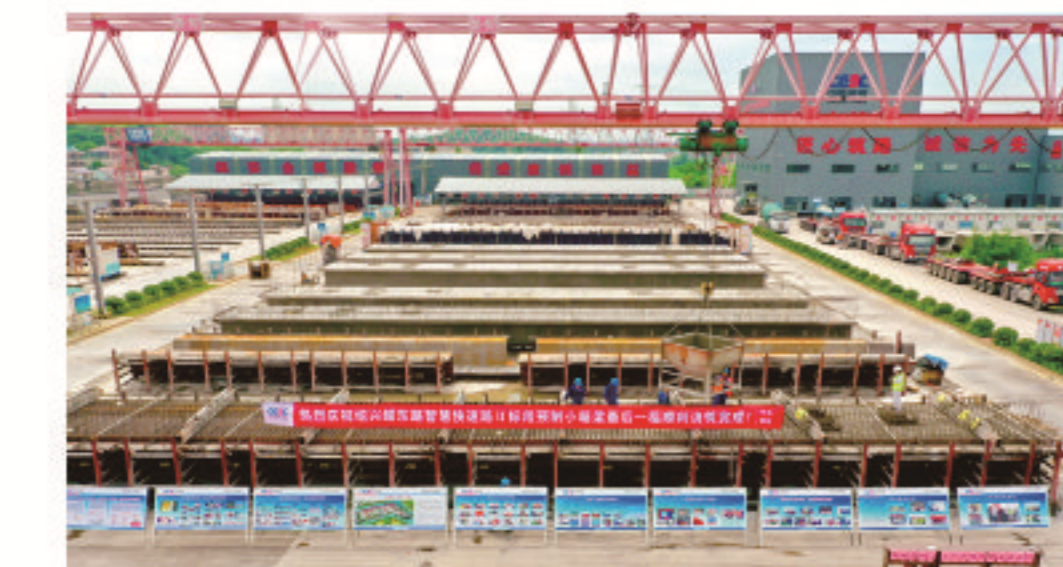
绍兴越东路智慧快速路II标段最后一幅小箱梁浇筑完成。
